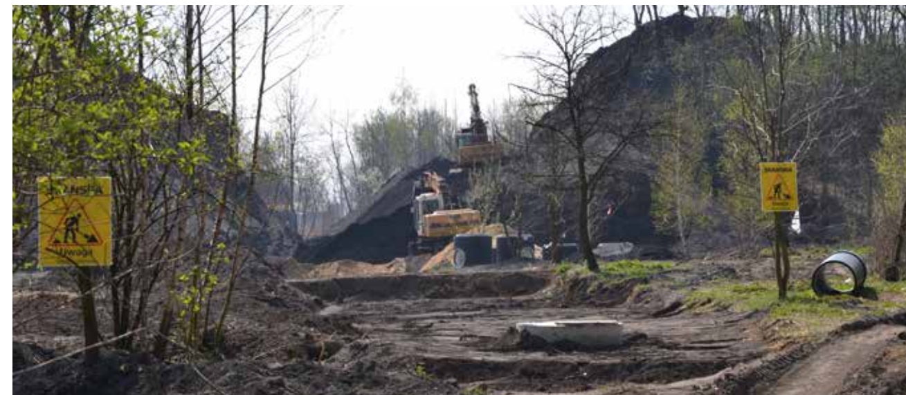
Budowa drogi do terenów inwestycyjnych przy ul. Zielonej
